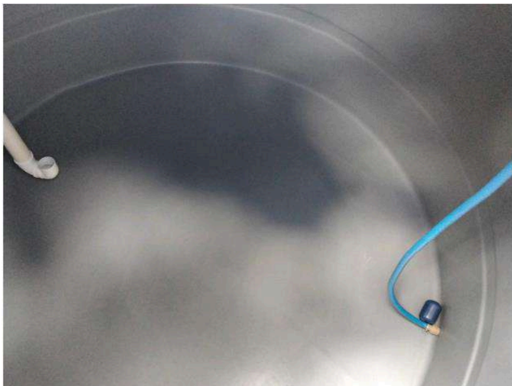
Figura 7: interior da cisterna após a instalação.
