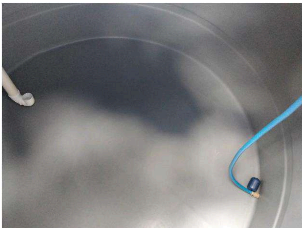
Figura 7: interior da cisterna após a instalação.
