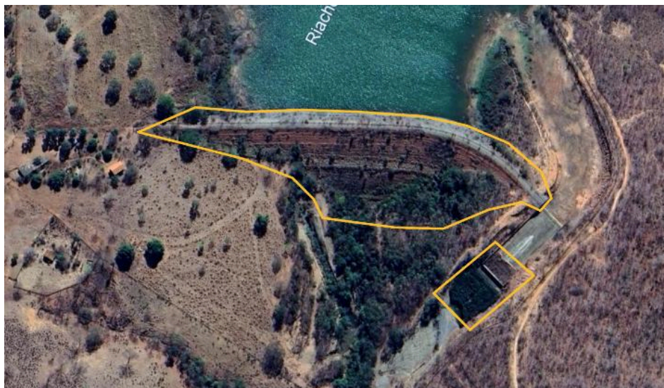
Figura 1 – Vista superior da Barragem São Gregório com indicação da área a ser realizada limpeza de vegetação: talude de montante, crista, talude de jusante, região a jusante e parte do canal de aproximação/restituição demarcada.
