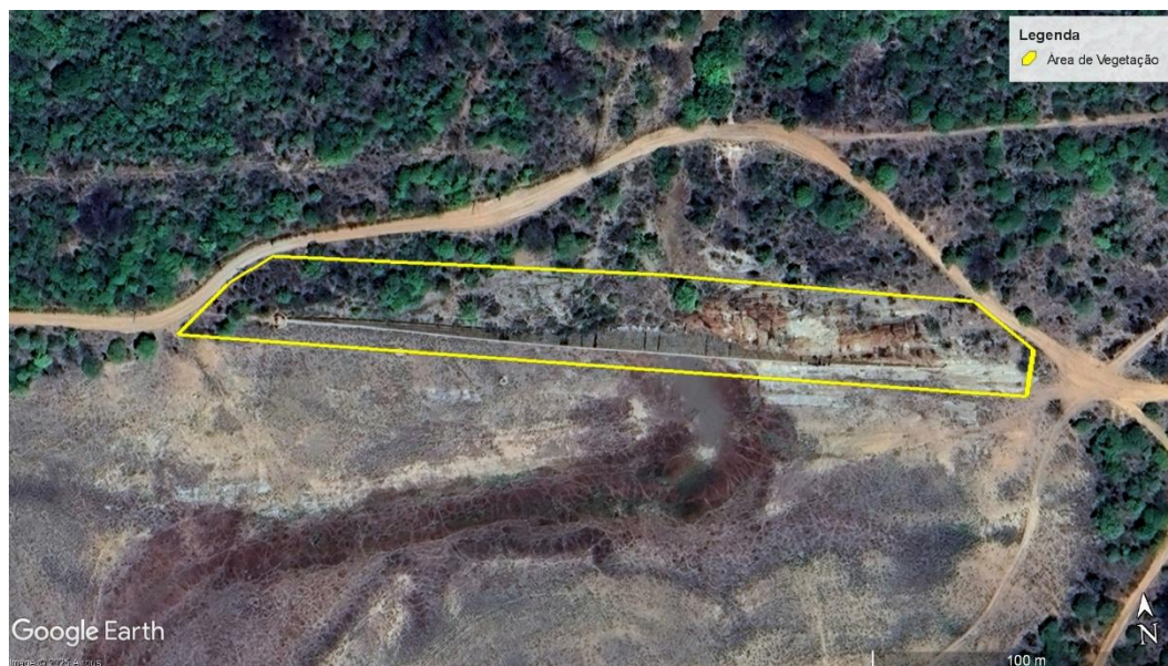
Figura 3 – Vista superior da Barragem Brejo com indicação da área a ser realizada limpeza de vegetação: estrutura da barragem, área do reservatório, região a jusante e ombreiras.
