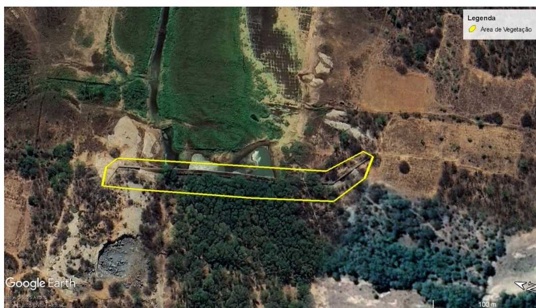
Figura 4 – Vista superior da Barragem Boqueirão com indicação da área a ser realizada limpeza de vegetação: estrutura da barragem, área do reservatório, região a jusante e ombreiras.
