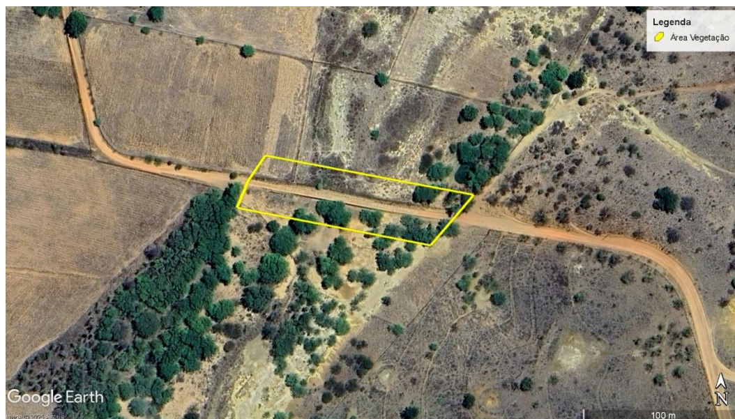
Figura 1 – Vista superior da Barragem Sitio Lamberdor com indicação da área a ser realizada limpeza de vegetação: estrutura da barragem, área do reservatório, região a jusante e ombreiras.
