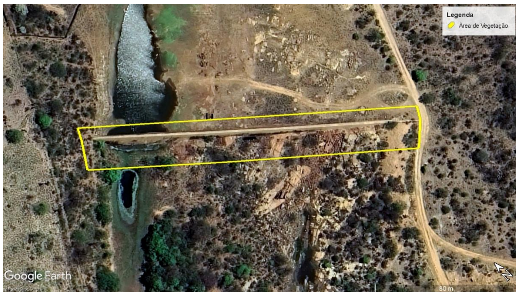
Figura 2 – Vista superior da Barragem Poço da Onça com indicação da área a ser realizada limpeza de vegetação: estrutura da barragem, área do reservatório, região a jusante e ombreiras.
