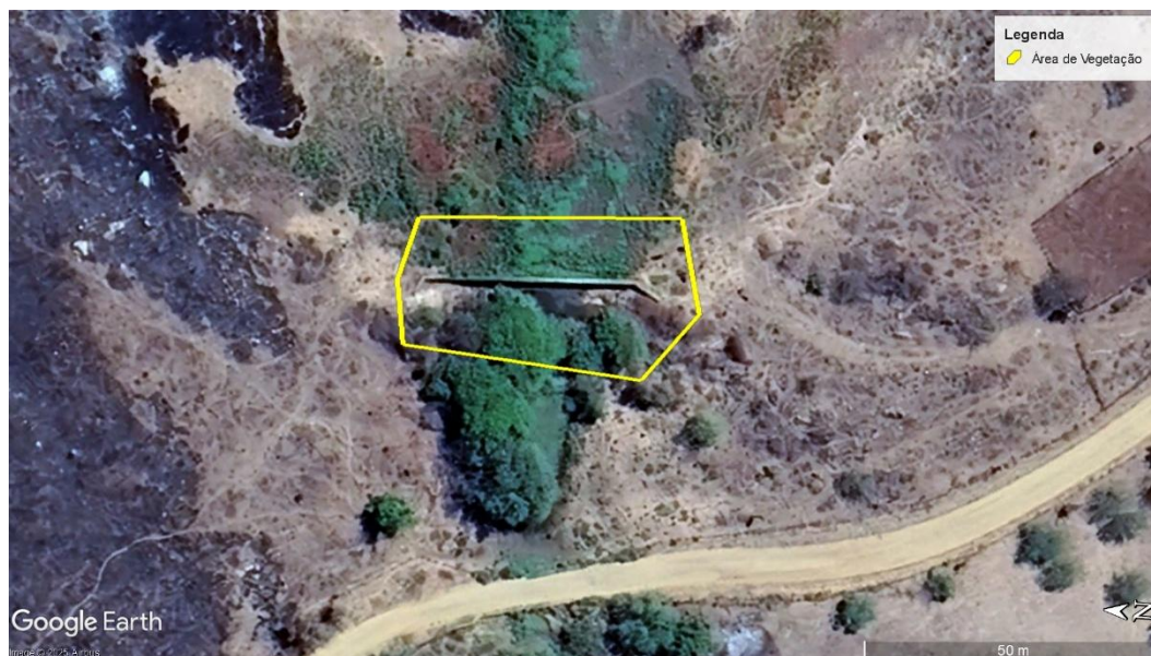
Figura 5 – Vista superior da Barragem Paus Grandes com indicação da área a ser realizada limpeza de vegetação: estrutura da barragem, área do reservatório, região a jusante e ombreiras.
