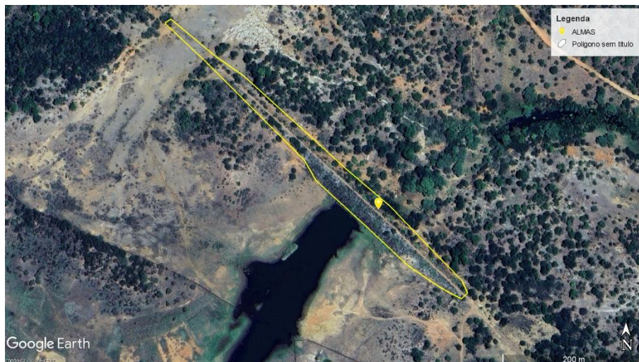
Figura 4 – Vista superior da Barragem Almas com indicação da área a ser realizada limpeza de vegetação: talude de montante, crista, talude de jusante, região a jusante e parte do canal de aproximação/restituição demarcada.
