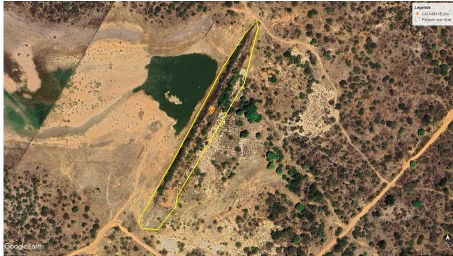
Figura 1 – Vista superior da Barragem Cacimba Velha com indicação da área a ser realizada limpeza de vegetação: talude de montante, crista, talude de jusante, região a jusante e parte do canal de aproximação/restituição demarcada.
