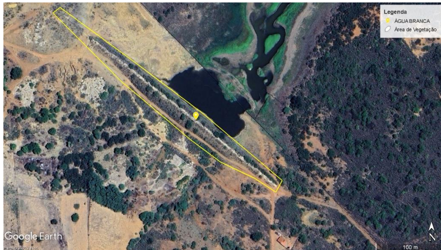
Figura 2 – Vista superior da Barragem Água Branca com indicação da área a ser realizada limpeza de vegetação: talude de montante, crista, talude de jusante, região a jusante e parte do canal de aproximação/restituição demarcada.
