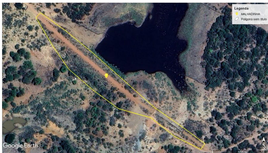
Figura 5 – Vista superior da Barragem Malhadinha com indicação da área a ser realizada limpeza de vegetação: talude de montante, crista, talude de jusante, região a jusante e parte do canal de aproximação/restituição demarcada.
