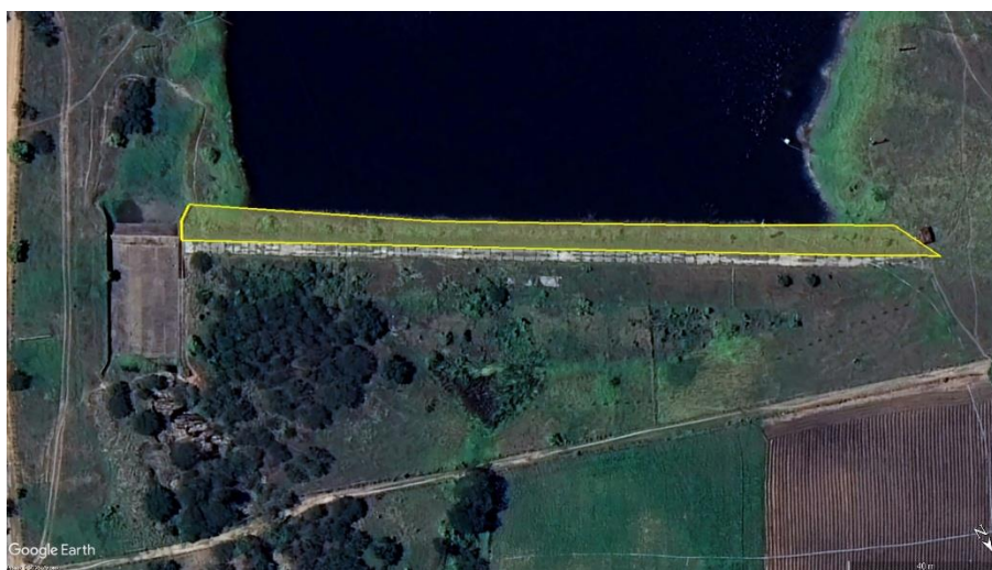
Figura 4 – Vista superior da Barragem Itapicuru com indicação da área a ser realizada limpeza e desobstrução do enrocamento.
