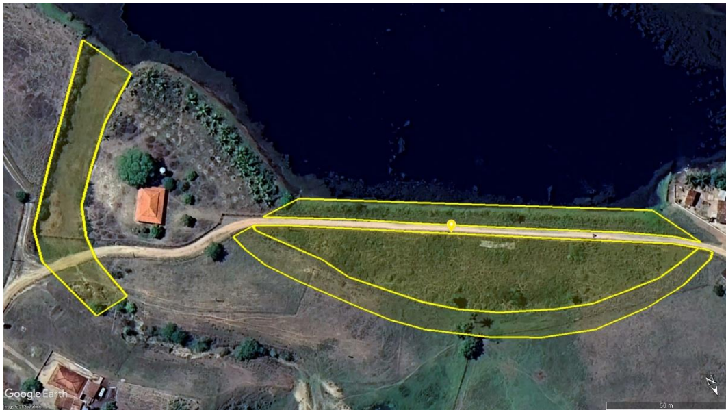
Figura 1 – Vista superior da Barragem Marcado dos Pereiras com indicação da área a ser realizada limpeza de vegetação: maciço da barragem, área do reservatório, região a jusante, vertedouro e ombreiras.
