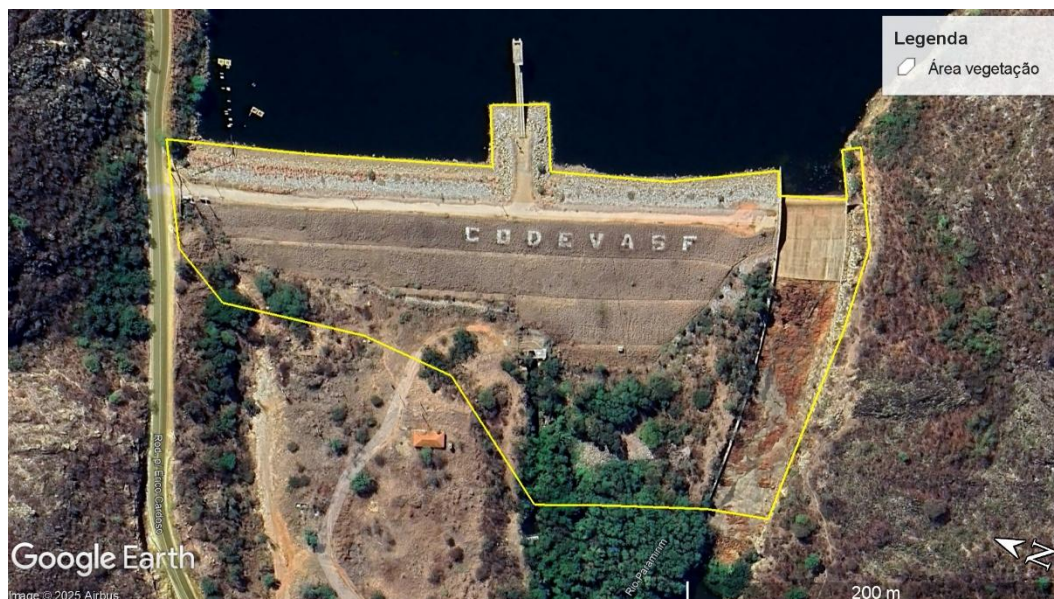
Figura 1 – Vista superior da Barragem Zabumbão com indicação da área a ser realizada limpeza de vegetação: talude de montante, crista, talude de jusante, região a jusante e parte do canal de aproximação/restituição demarcada.
