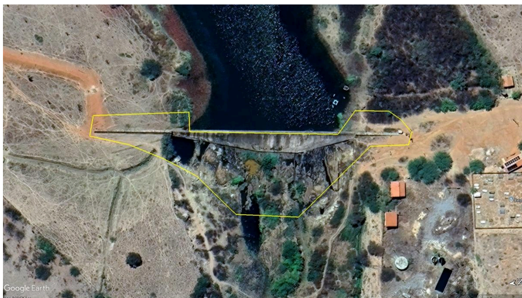
Figura 2 – Vista superior da Barragem Rio da Caixa com indicação da área a ser realizada limpeza de vegetação: estrutura da barragem, área do reservatório, região a jusante, vertedouro e ombreiras.
