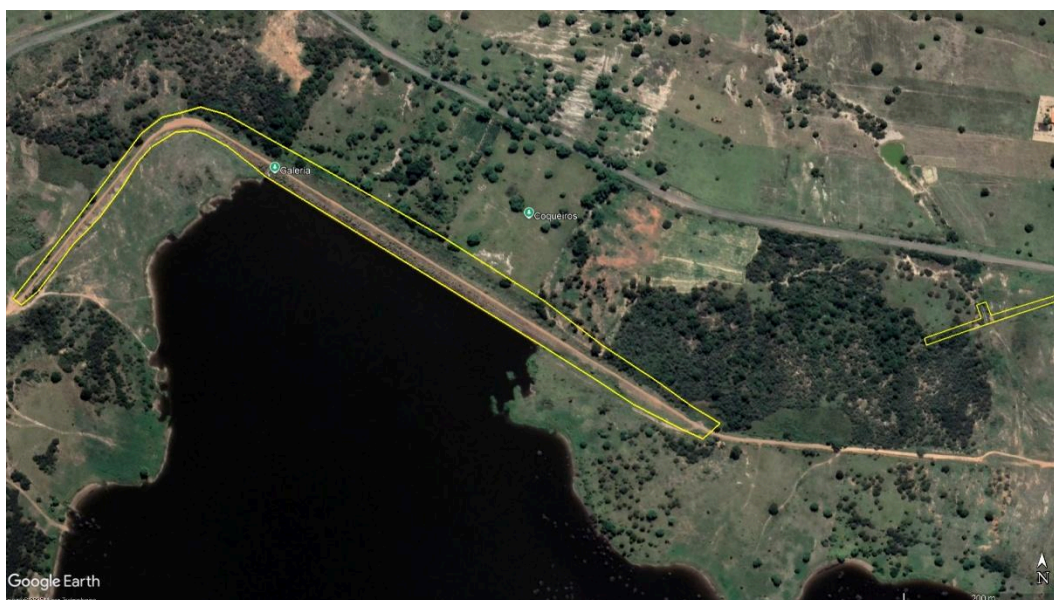
Figura 1 – Vista superior da Barragem Macaúbas com indicação da área a ser realizada limpeza de vegetação: maciço da barragem, área do reservatório, região a jusante, vertedouro e ombreiras.
