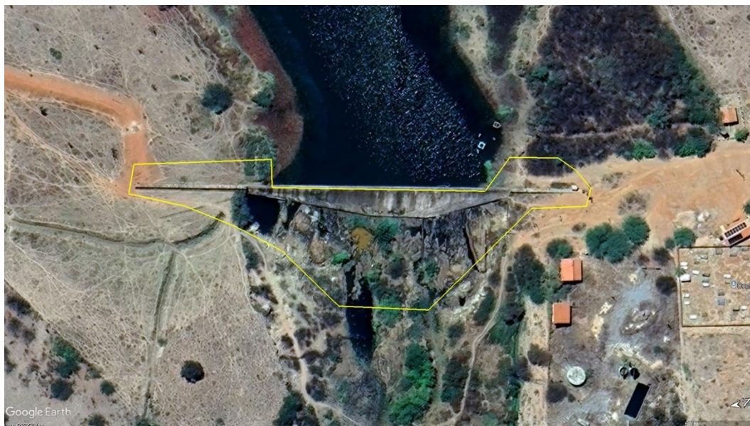
Figura 2 – Vista superior da Barragem Rio da Caixa com indicação da área a ser realizada limpeza de vegetação: estrutura da barragem, área do reservatório, região a jusante, vertedouro e ombreiras.
