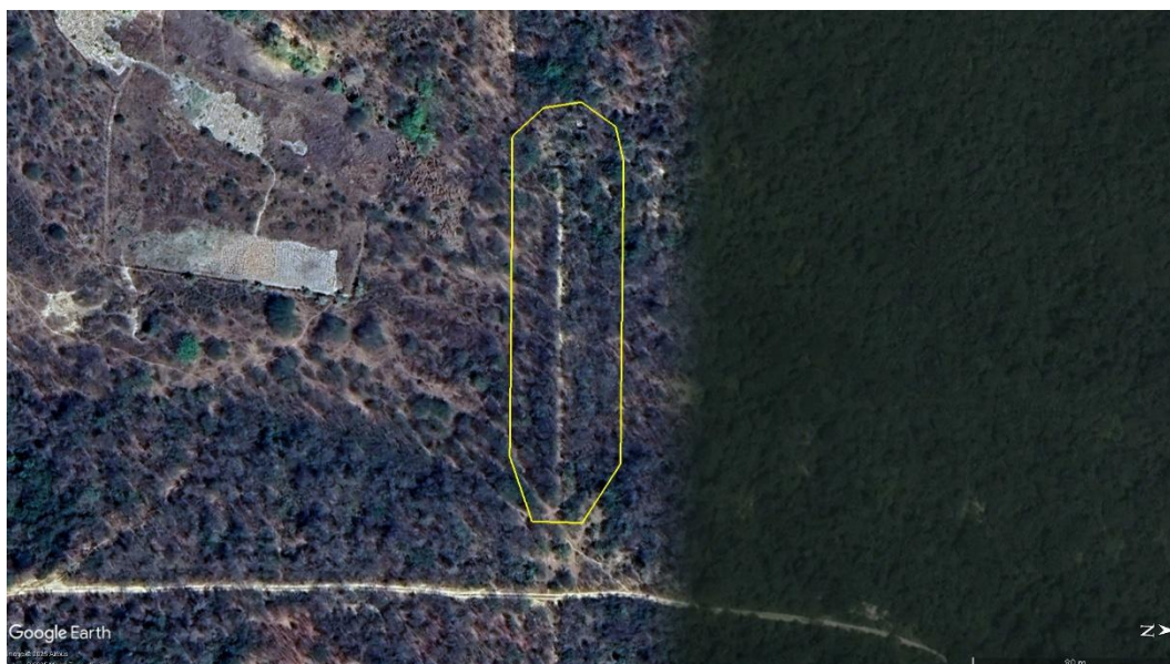
Figura 3 – Vista superior da Barragem Baixão do Cecílio com indicação da área a ser realizada limpeza de vegetação: talude de montante, crista, talude de jusante, região a jusante e parte do canal de aproximação/restituição demarcada.
