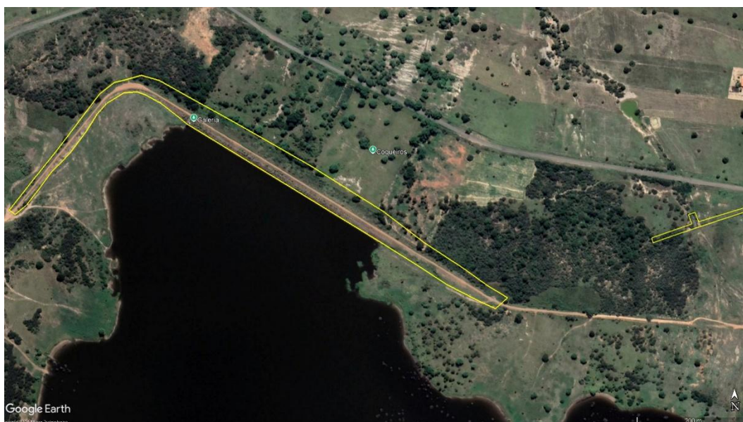
Figura 1 – Vista superior da Barragem Macaúbas com indicação da área a ser realizada limpeza de vegetação: maciço da barragem, área do reservatório, região a jusante, vertedouro e ombreiras.
