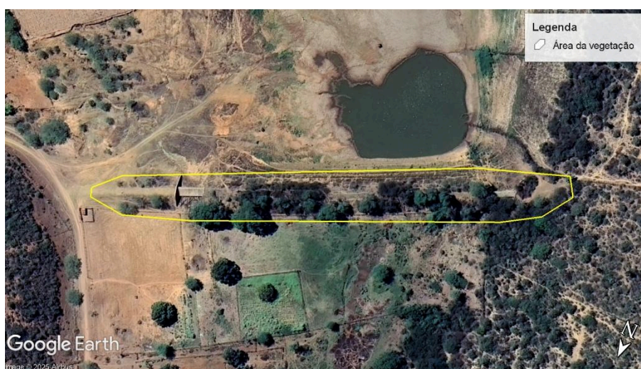
Figura 5 – Vista superior da Tamboril II com indicação da área a ser realizada limpeza de vegetação: talude de montante, crista, talude de jusante, região a jusante e parte do canal de aproximação/restituição demarcada.
