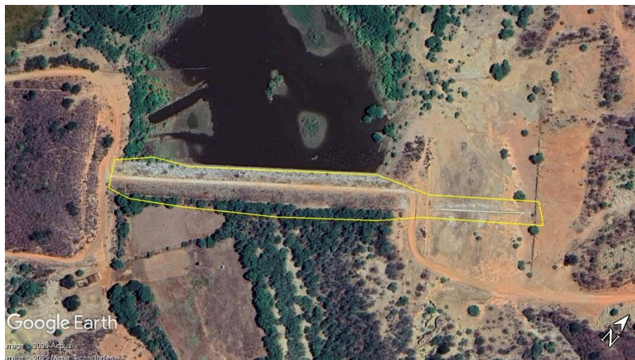
Figura 2 – Vista superior da Barragem Poço da Pedra com indicação da área a ser realizada limpeza de vegetação: talude de montante, crista, talude de jusante, região a jusante e parte do canal de aproximação/restituição demarcada.
