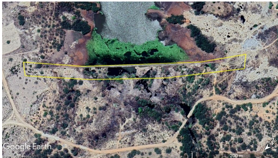
Figura 1 – Vista superior da Barragem Poções com indicação da área a ser realizada limpeza de vegetação: estrutura da barragem, área do reservatório, região a jusante e ombreiras.
