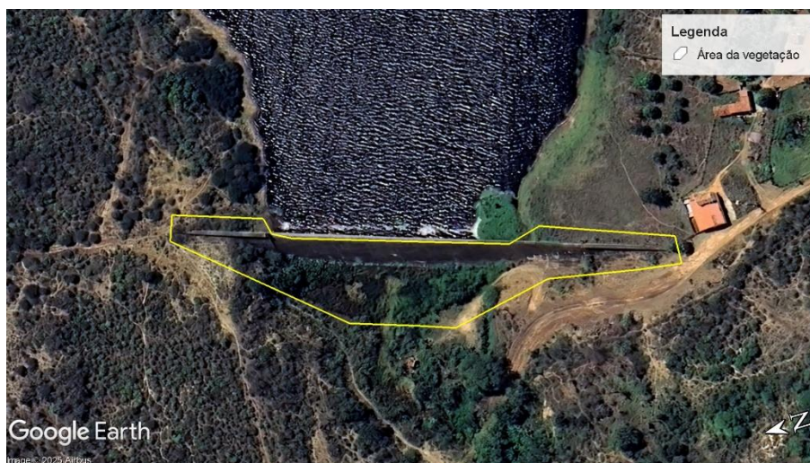
Figura 4 – Vista superior da Barragem Caatinga de Moura com indicação da área a ser realizada limpeza de vegetação: estrutura da barragem, área do reservatório, região a jusante e ombreiras.
