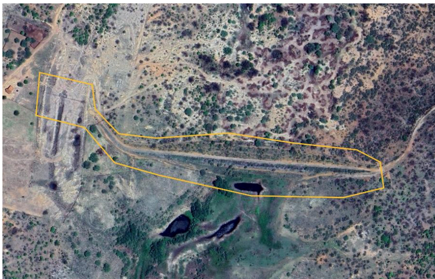
Figura 2 – Vista superior da Barragem Caiçara com indicação da área a ser realizada limpeza de vegetação: talude de montante, crista, talude de jusante, região a jusante e parte do canal de aproximação/restituição demarcada.
