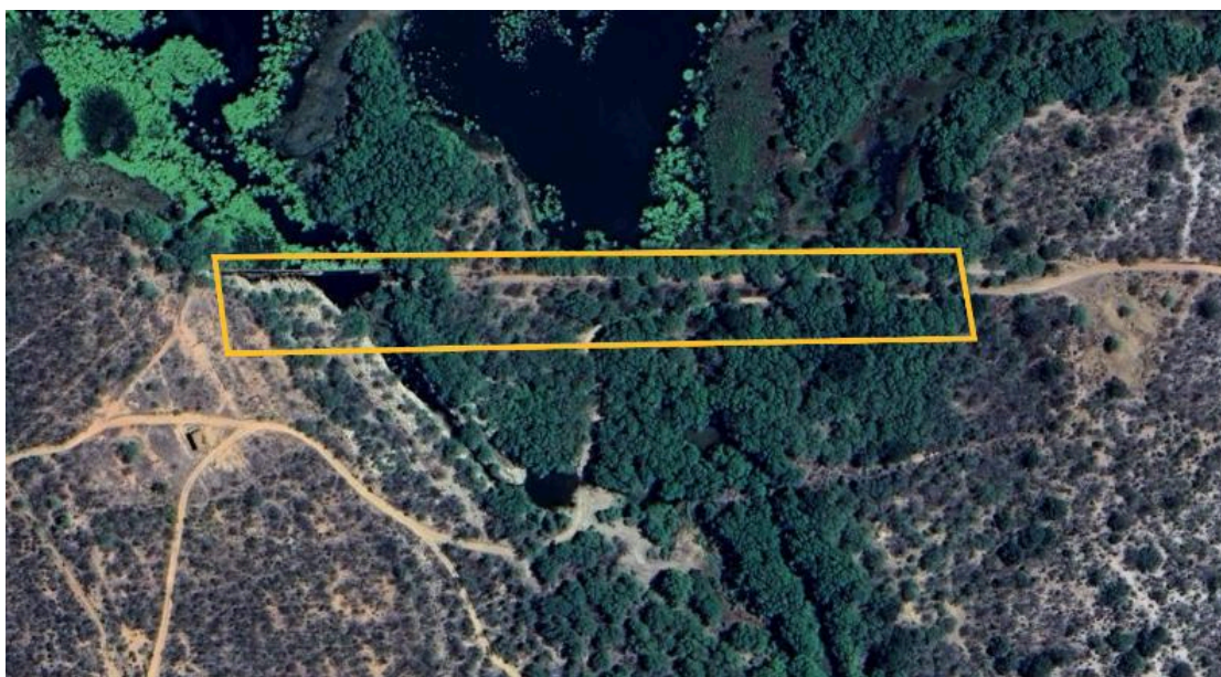
Figura 6 – Vista superior da Barragem Algodões com indicação da área a ser realizada limpeza de vegetação: talude de montante, crista, talude de jusante, região a jusante e parte do canal de aproximação/restituição demarcada.
