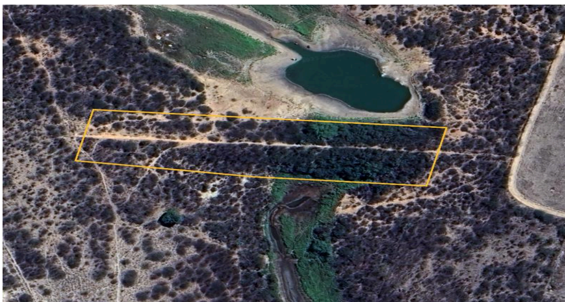
Figura 7 – Vista superior da Barragem Alto Grande com indicação da área a ser realizada limpeza de vegetação: talude de montante, crista, talude de jusante, região a jusante.
