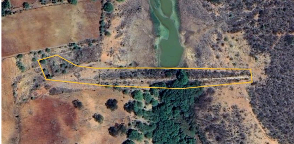
Figura 3 – Vista superior da Barragem Manoel Rodrigues com indicação da área a ser realizada limpeza de vegetação: talude de montante, crista, talude de jusante, região a jusante e parte do canal de aproximação/restituição demarcada.
