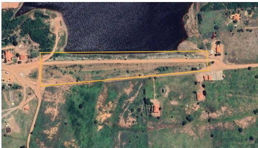
Figura 1 – Vista superior da Barragem Jacu com indicação da área a ser realizada limpeza de vegetação: talude de montante, crista, talude de jusante, região a jusante e parte do canal de aproximação/restituição demarcada.
