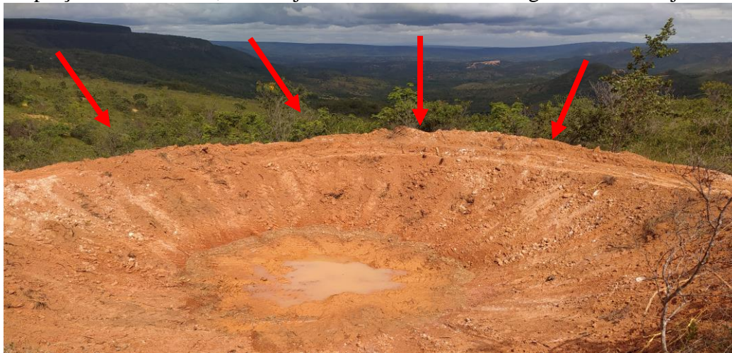
Figura 1. Demonstrando (setas) a execução do “cordão” de solo na parte de “fora” da crista da bacia de captação de enxurrada, com objetivo de escoamento de água no talude à jusante.
