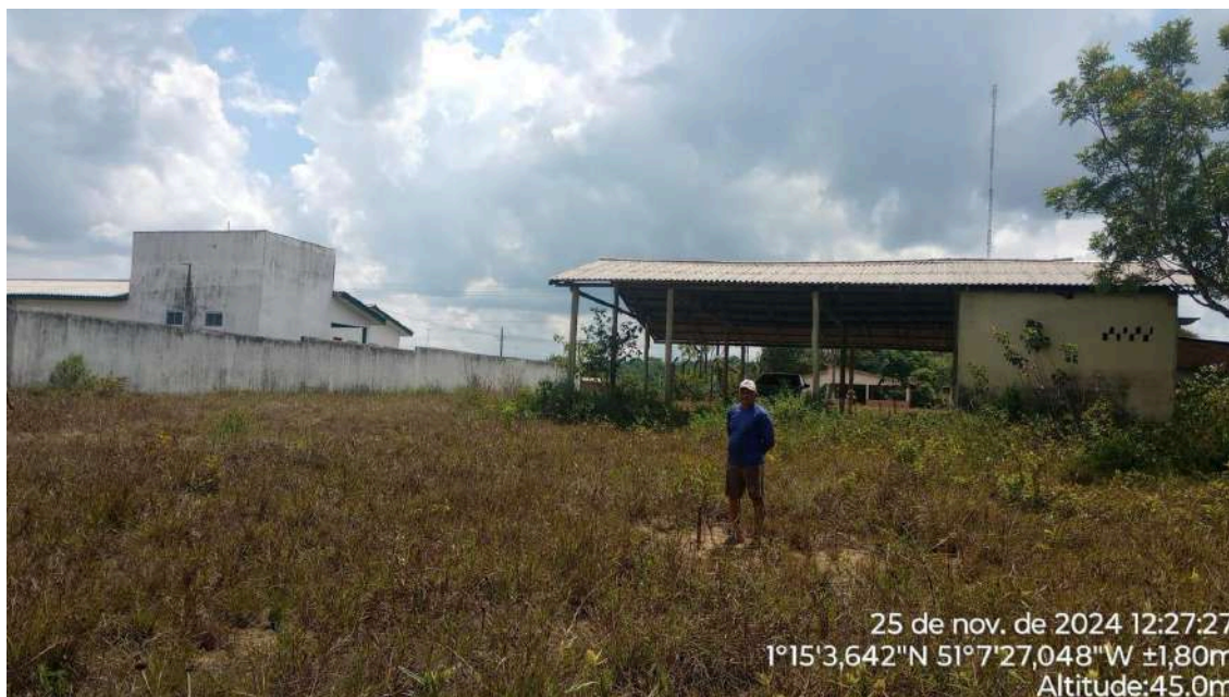
Fotografia 2: situação geral do local do poço.
