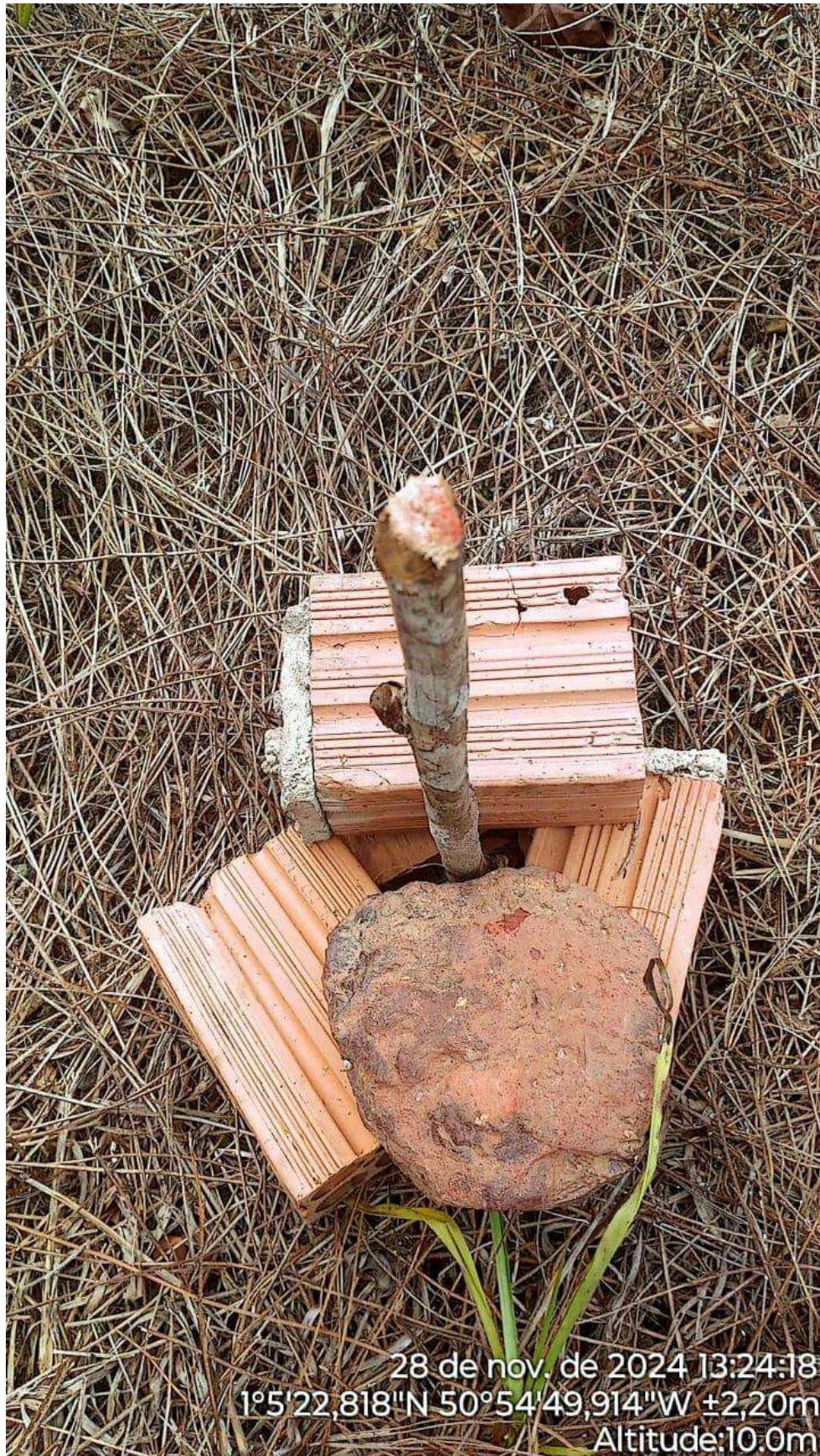
Fotografia 1: marcação do local exato da perfuração do poço tubular.
