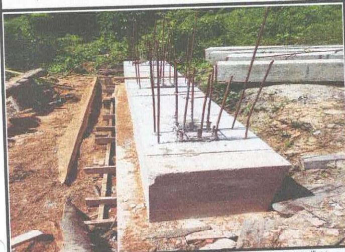
Confeção, lançamento e adensamento de concreto Fck=35 Mpa com aditivos específicos
