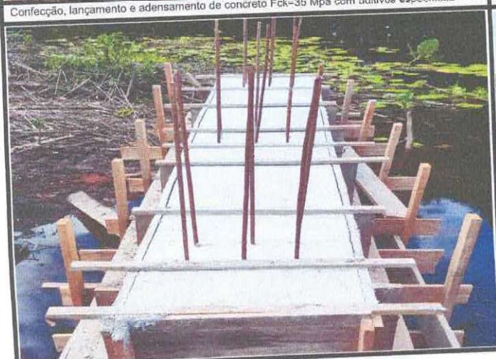
Confeção, lançamento e adensamento de concreto Fck=35 Mpa com aditivos específicos
