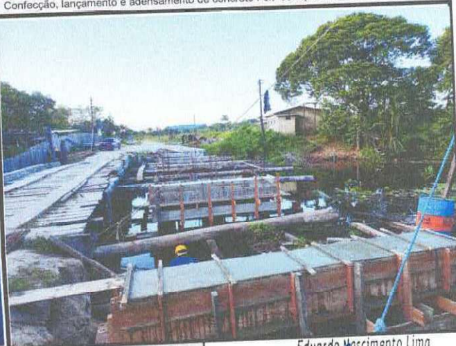
Confeção, lançamento e adensamento de concreto Fck=35 Mpa com aditivos específicos
