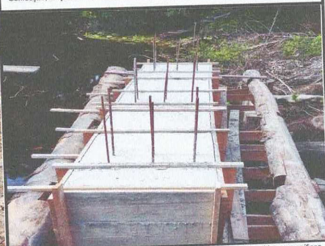
Confeção, lançamento e adensamento de concreto Fck=35 Mpa com aditivos específicos
